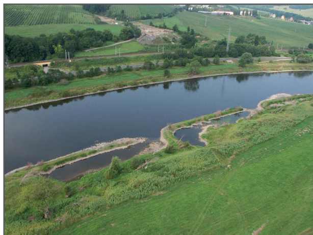
Obr. 6-7a: Koncentrační výhony na českém dolním Labi u Nebočad (J. Medek, Povodí Labe, státní podnik)
