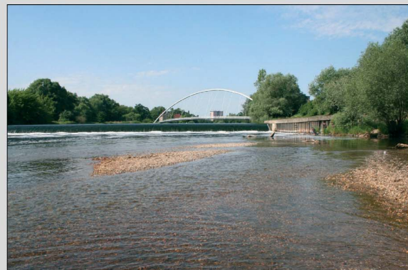
Stadtwehr Dessau an der Mulde, Juni 2012 (Foto: Jährling, LHW). Jez ve městě Dessau na řece Mulde, červen 2012 (Foto: Jährling, LHW).
